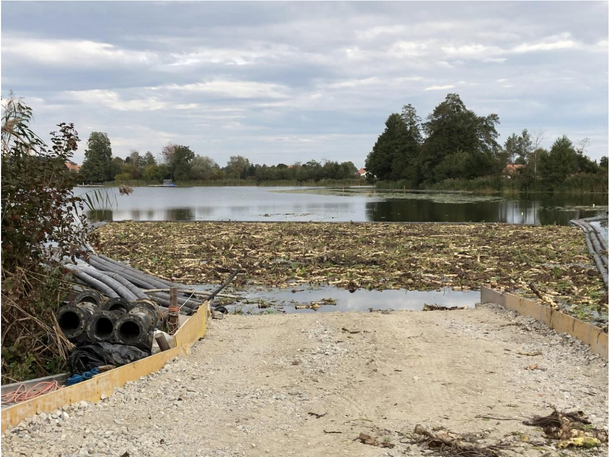
Der Seezugang für die Saugbagger.
