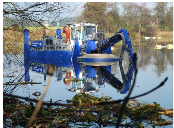
Der Saugbagger an der Arbeit.
