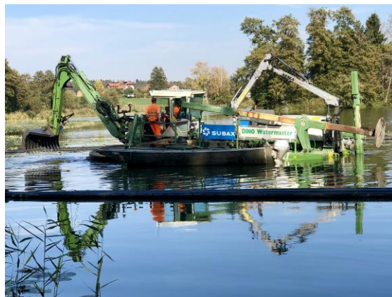
Der Saugbagger an der Arbeit.
