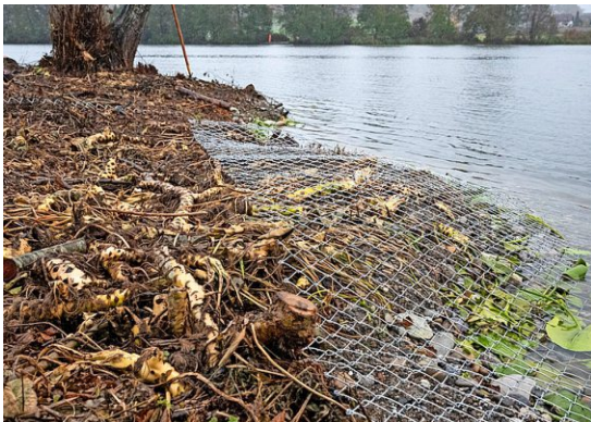
Die Maschendrahtgitter sorgen auch für Stabilität.
